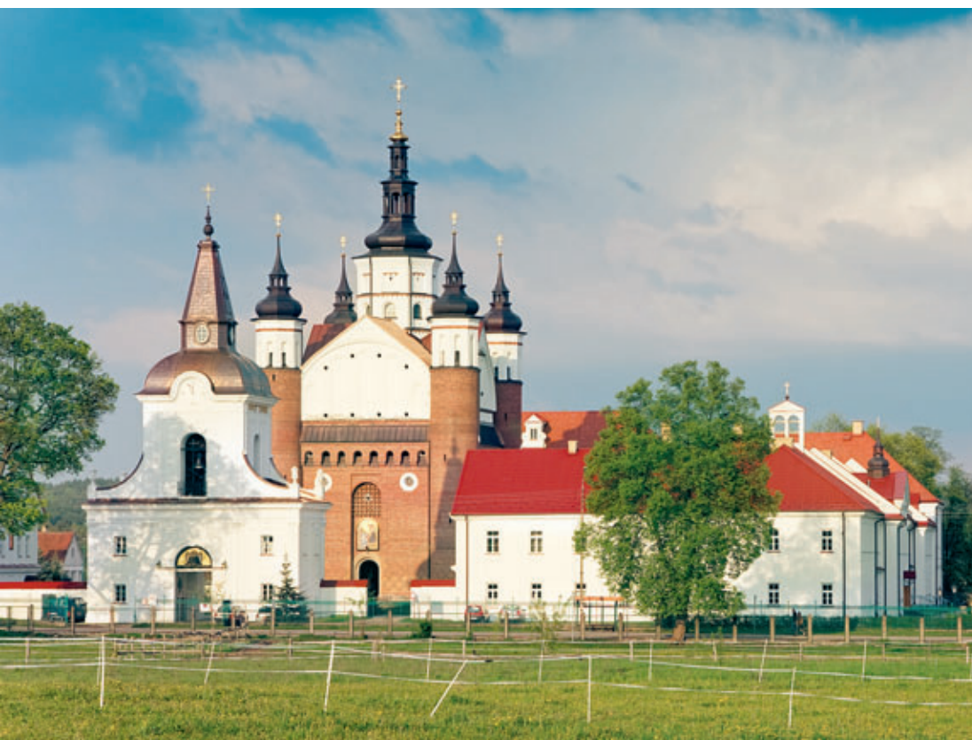
Supraśl, kompleks klasztorny z obronną cerkwią
