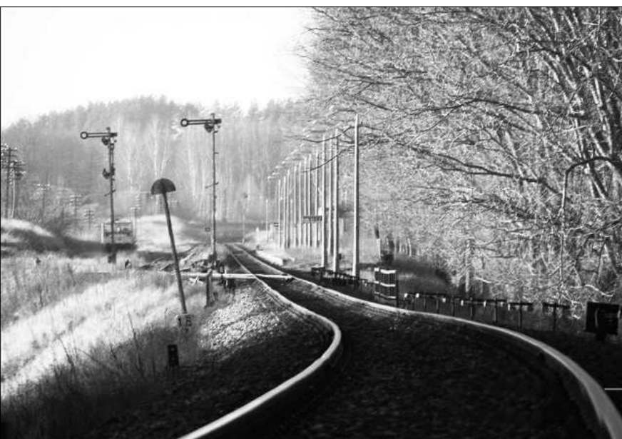
Stacja kolejowa w Sidrze. Źródło: Internet.
