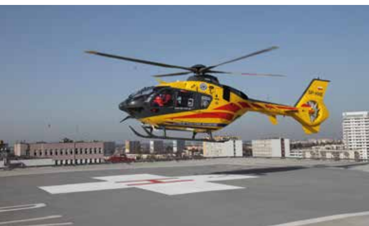
Lądowisko z podgrzewaną nawierzchnią
