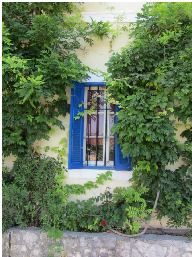
Fotografia 26. Okiennice pomalowane na niebiesko, źródło: zdjęcie własne
