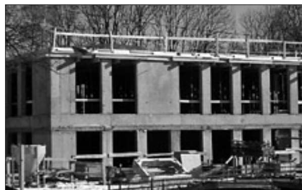
Tak kończymy. Budowa gmachu dla wydziału pielęgniarstwa.
