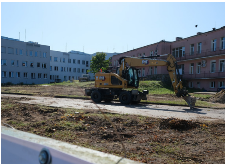
Budowa nowych klinik zakaźnych to znak, że to szpital w Dojlidach będzie teraz inwestycyjnym centrum Uczelni, fot. Wojciech Więcko
