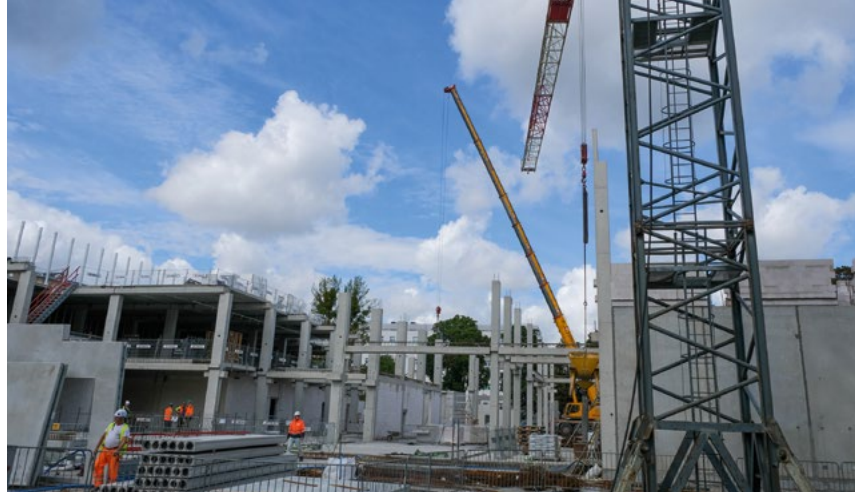
UMB w budowie - Abecadło Medycyny to ogromny kompleks sal wykładowych i seminarijnych, a do tego centrum egzaminów standaryzowanych (OSCE) w odpowiedzi na rosnące potrzeby Uczelni i studentów
