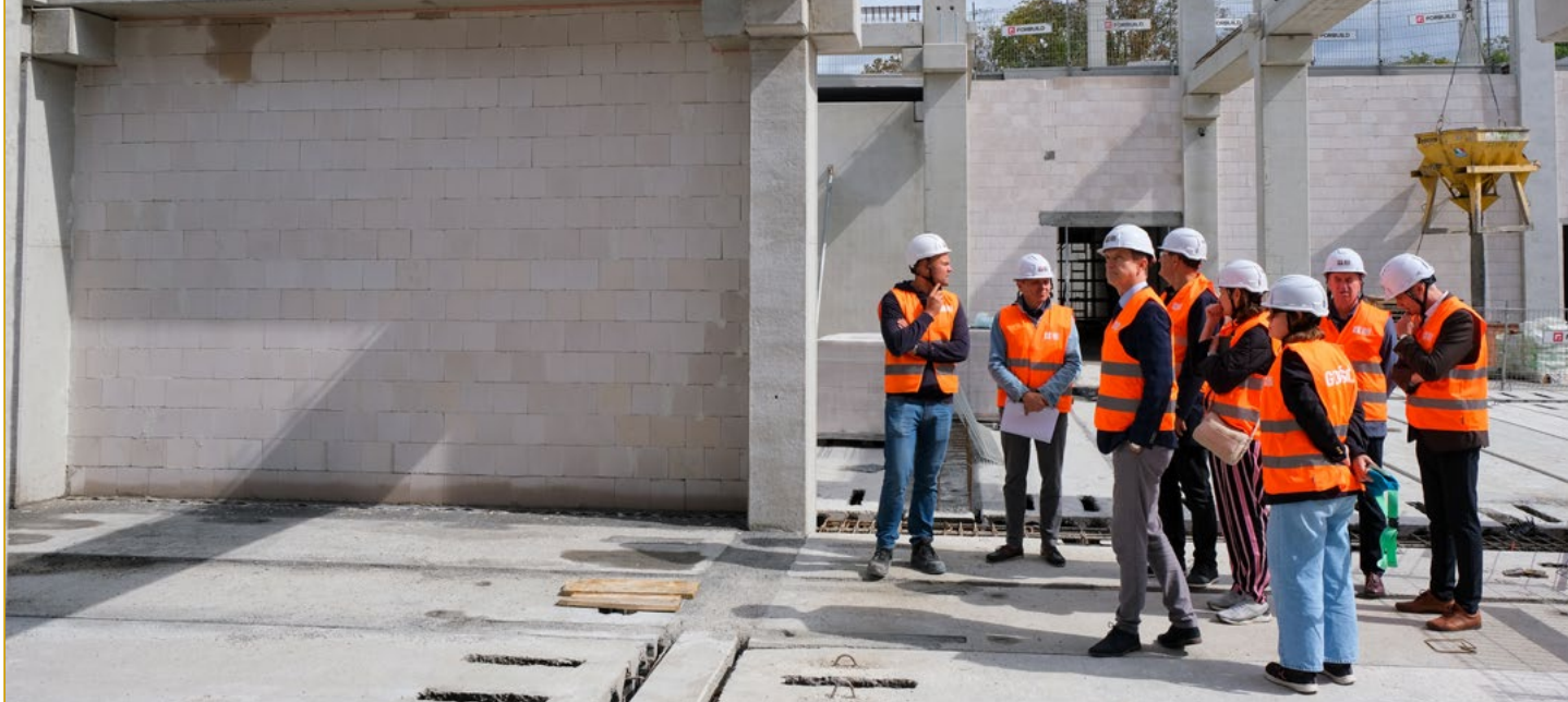
Budowa Centrum Dydaktycznego „Abecadło”. W najbliższych latach UMB chce zrealizować inwestycje warte przeszło miliard złotych
