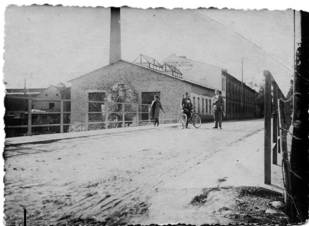
Szkoła Rzemieślniczo-Przemysłowa przy ul. Antoniukowskiej, 1930 r.
