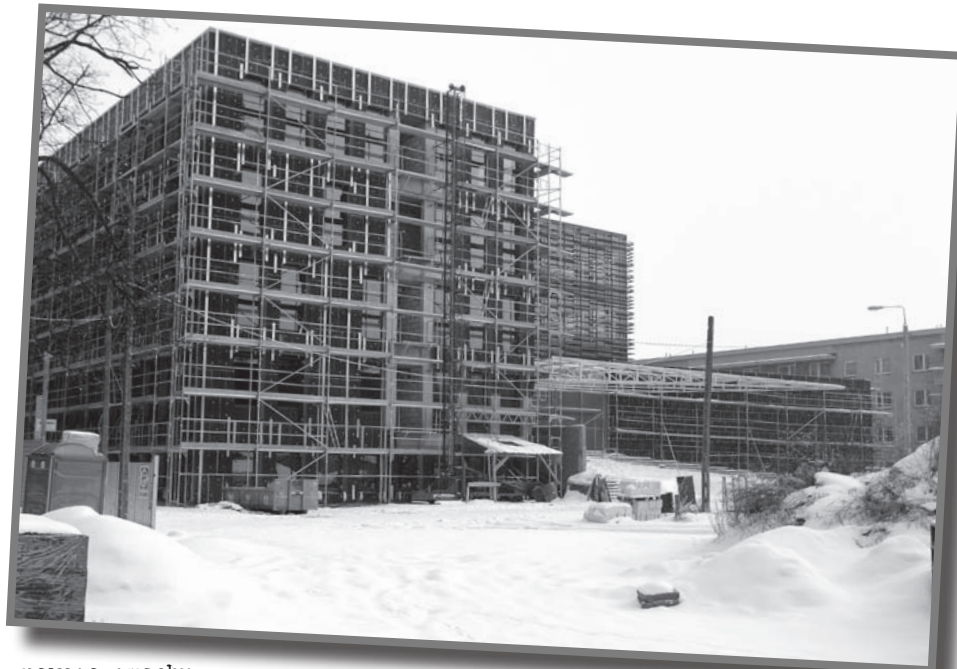
Plac budowy nowego gmachu Wydziału Pielęgniarstwa i Ochrony Zdrowia UMB.
