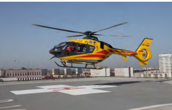
Lądowisko z podgrzewaną nawierzchnią
