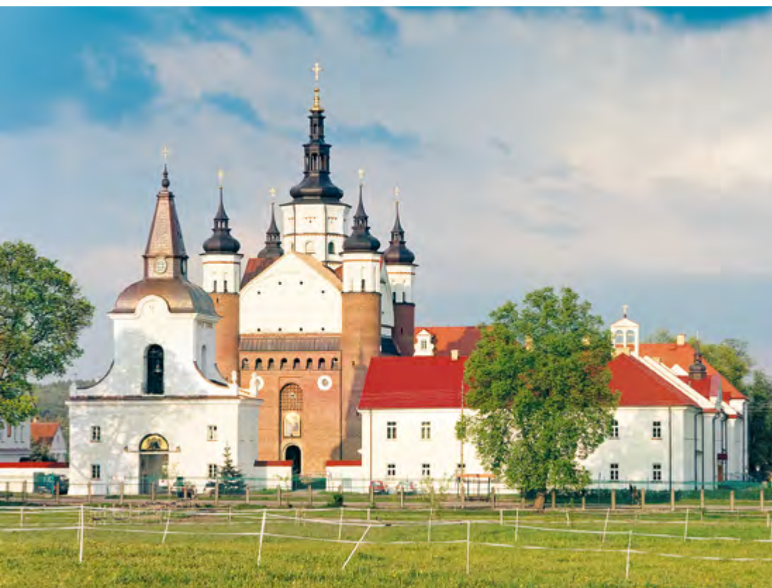
Supraśl, kompleks klasztorny z obronną cerkwią
